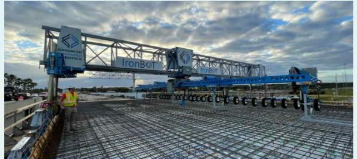
〈 Advanced Construction Robotics사의 철근 설치 솔루션 (좌: TyBOT, 우: IronBOT) 〉
